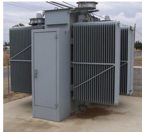
Foto-1 : Transformador fugando en exterior sin retención
