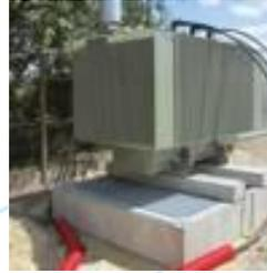
Chasis de extinción montados encima de cubetos de hormigón prefabricados o especiales
